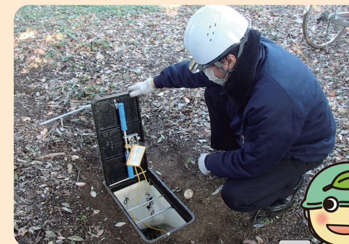
マンホール型災害用トイレの点検
