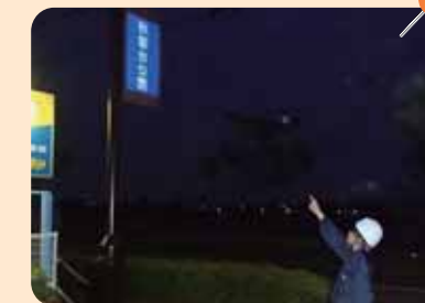
広域避難場所表示灯点検
