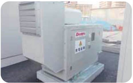
非常用発電機 サービスセンターが震災対応をするために必要な電源を確保する設備です。
