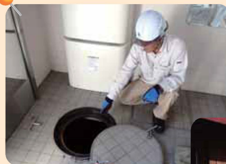
防災トイレ点検
