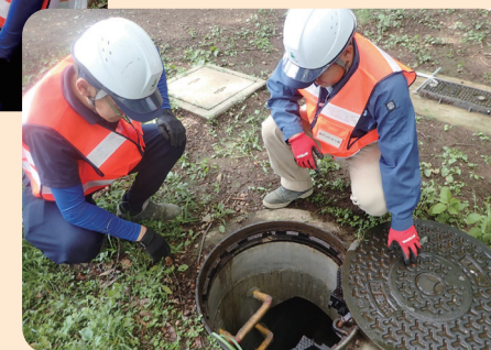
マンホール型災害用トイレピット内点検
