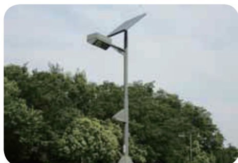
防災用照明灯 (ソーラー照明灯)
