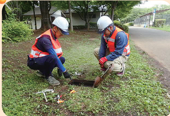
マンホール型災害用トイレ組立訓練
