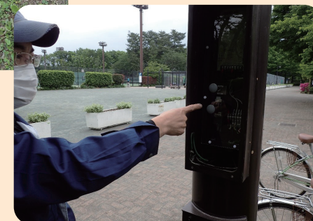
防災用照明灯点検
