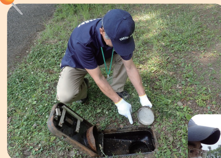
マンホール型災害用 トイレ点検
