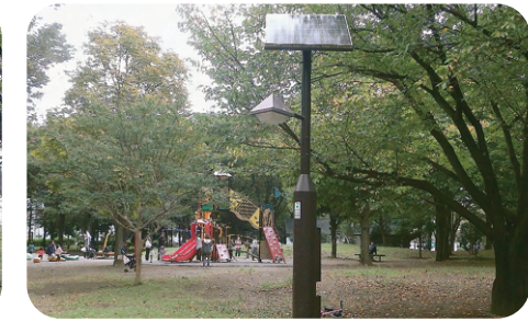
防災用照明灯(ソーラー照明灯)
