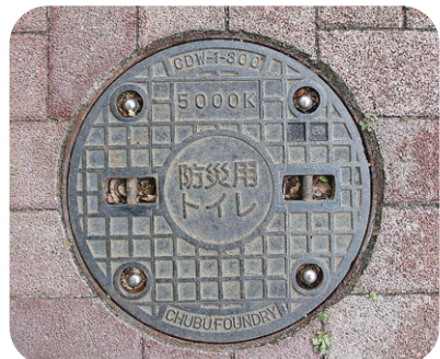
マンホール型災害用トイレ 災害時には、マンホールの蓋を外してトイレを設置することにより仮設トイレとして使用することができます。
