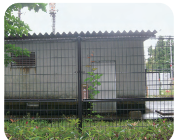
給水活動スペース (応急給水槽) 水道が被害を受けた場合に、応急給水活動を行うための施設です。
