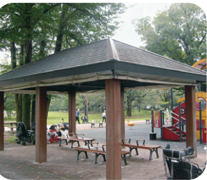
防災あずまや 災害時には、側面の幕を下ろし、救護スペース等として使用します。
