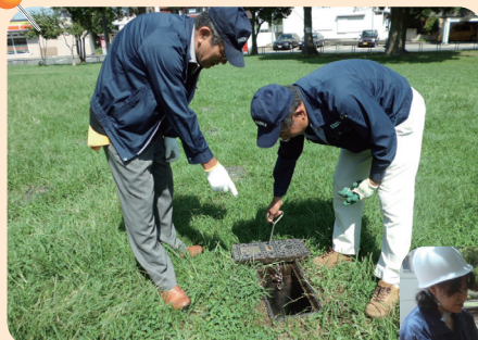
マンホール型災害用 トイレ点検
