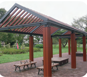
防災パーゴラ 災害時にテントをかけて、救護スペース等として使用します。
