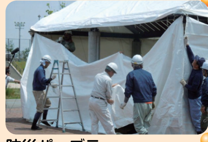
防災パーゴラ 設置訓練
