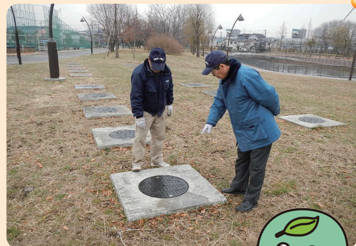
マンホール型災害用トイレの点検
