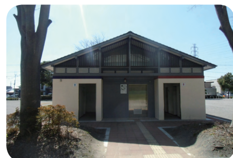
災害用トイレ (常設) 地下に便槽を持ち、災害時に給水や排水などのインフラが寸断された場合でも利用できるトイレです。災害時には、マンホールの蓋を開けて使用します。
