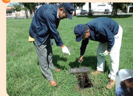
防災トイレ点検
