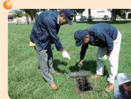
防災トイレ点検
