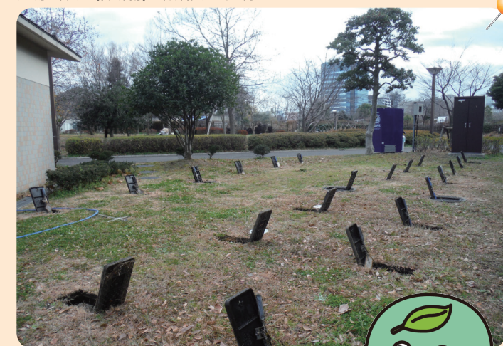
マンホール型災害用トイレの点検
