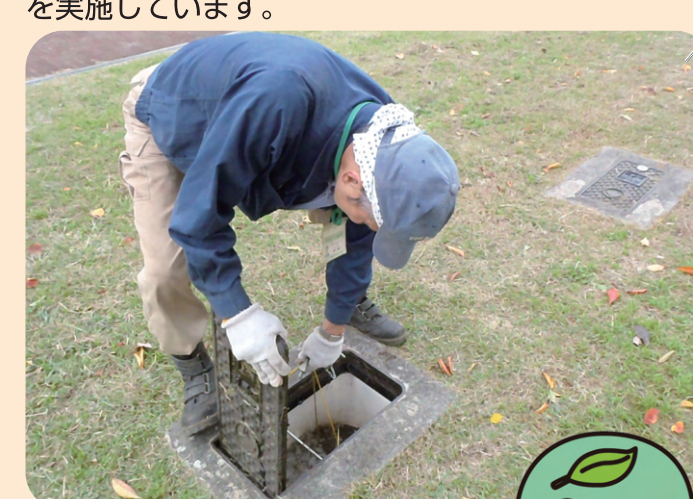
防災トイレの点検
