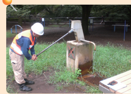
防災井戸ポンプの点検 (和田堀公園)
