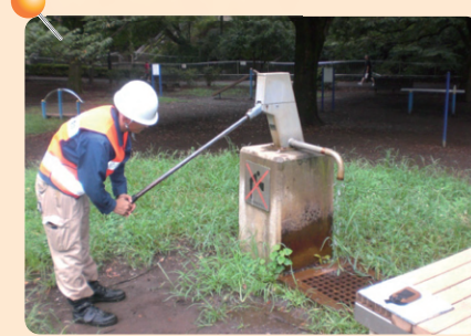
防災井戸ポンプの点検 (和田堀公園)
