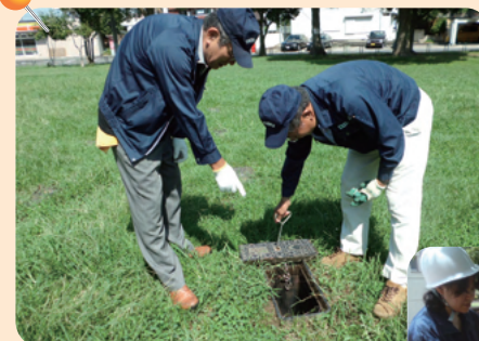
マンホール型災害用 トイレ点検
