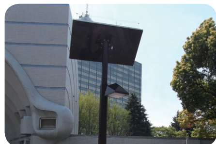
防災用照明灯（ソーラー照明灯）
