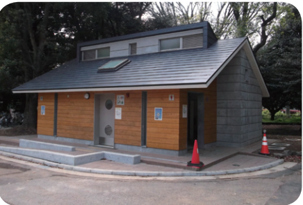
災害用トイレ（常設） 地下に便槽を持ち、災害時に給水や排水などのインフラが寸断された場合でも利用できるトイレです。
