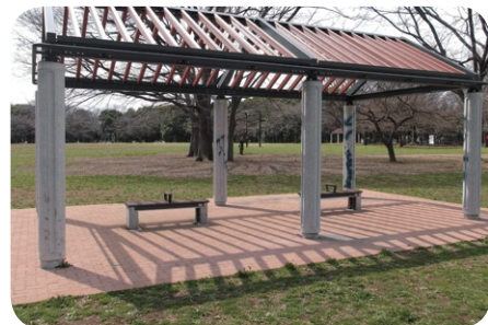
防災パーゴラ 災害時にテントをかけて、救護スペース等として使用します。
