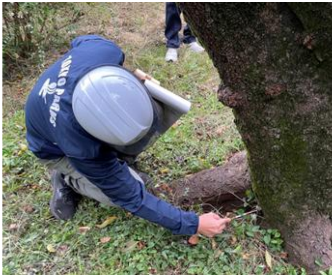
鋼棒貫入による腐朽の有無を確認
