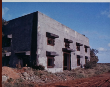
3 棟ある送信所の 1 棟
