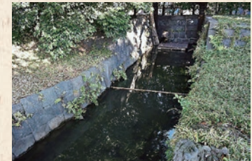
Toma de agua de mar
