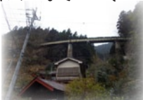
現在も遊歩道から当時の橋梁を見ることができる
