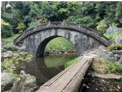
小石川後楽園「円月橋」 水戸徳川家二代藩主光圀の代に完成した小石川後楽園。当時の姿を留める貴重な建造物。
