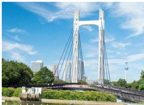
計画的な改修を行う大規模橋梁(木場公園)
