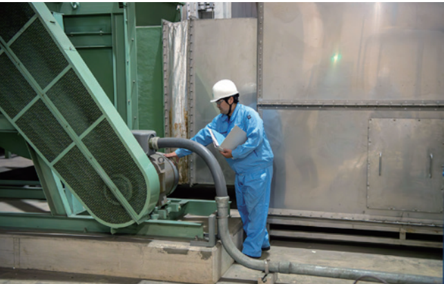
調節池の点検
