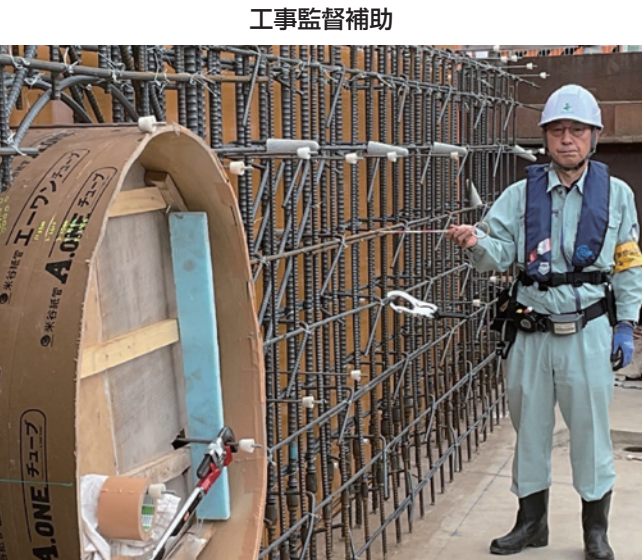
仙川整備工事
