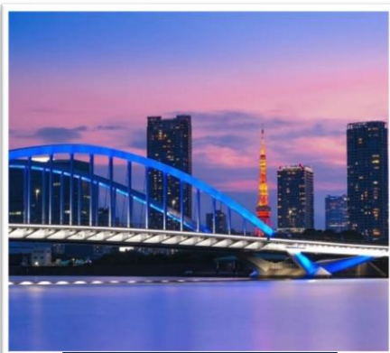
築地大橋と東京タワー
