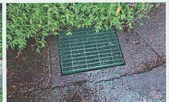
排水マスに亀甲ネット設置
